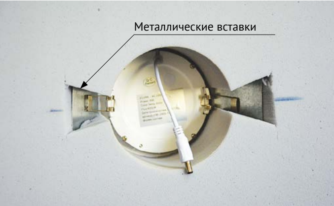
Армирующие вставки для монтажа светильников
