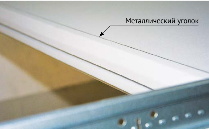
Вариант монтажа за врезанный уголок
