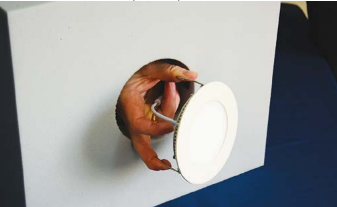
Армирующие вставки для монтажа светильников
