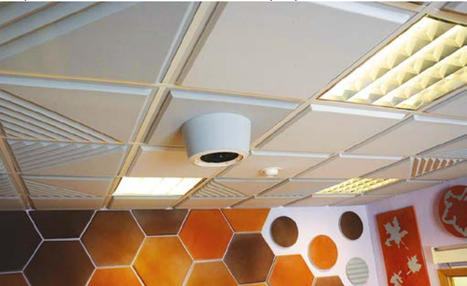
Потолочная панель со встроенным светильником
