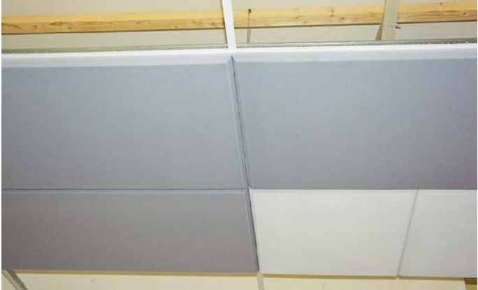
Фаска на потолочных панелях скрытого монтажа
